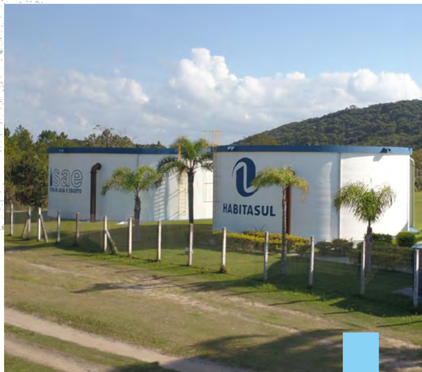
Reservatório SAE – Jurerê Internacional/SC
