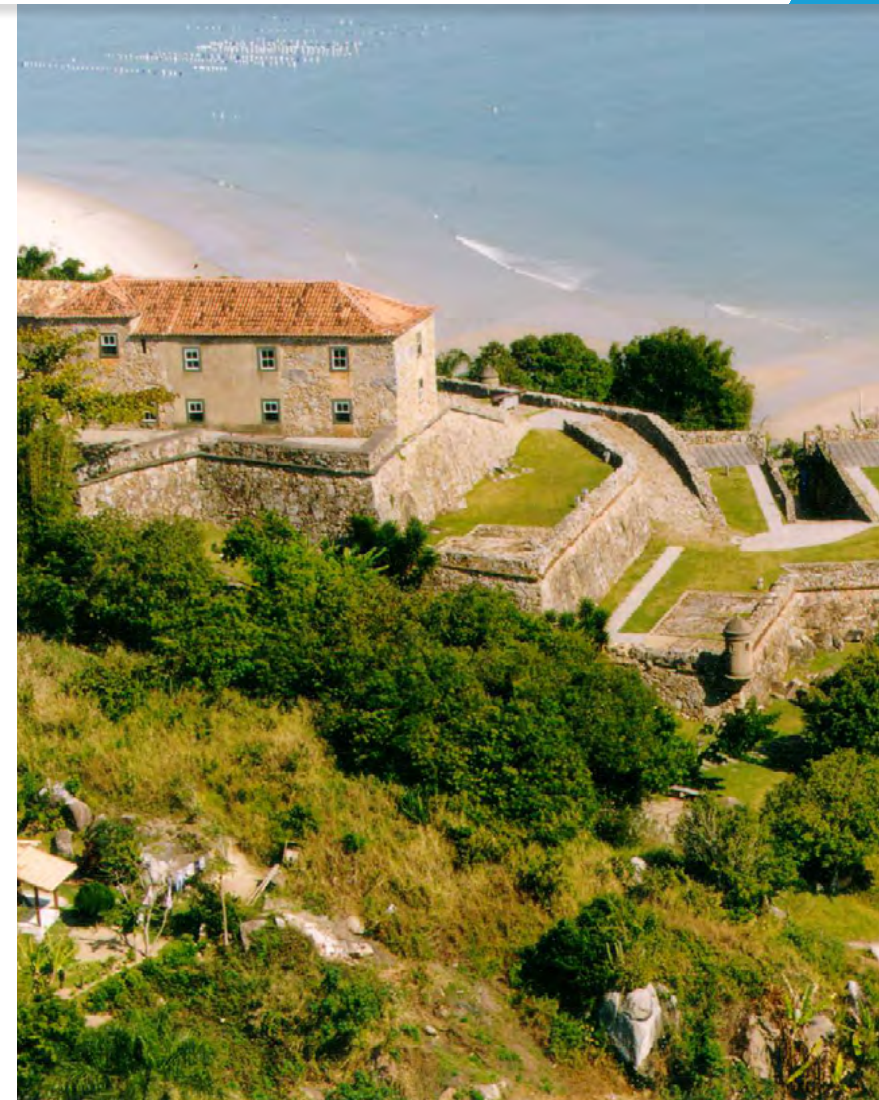
Fortaleza São José da Ponta Grossa/SC
