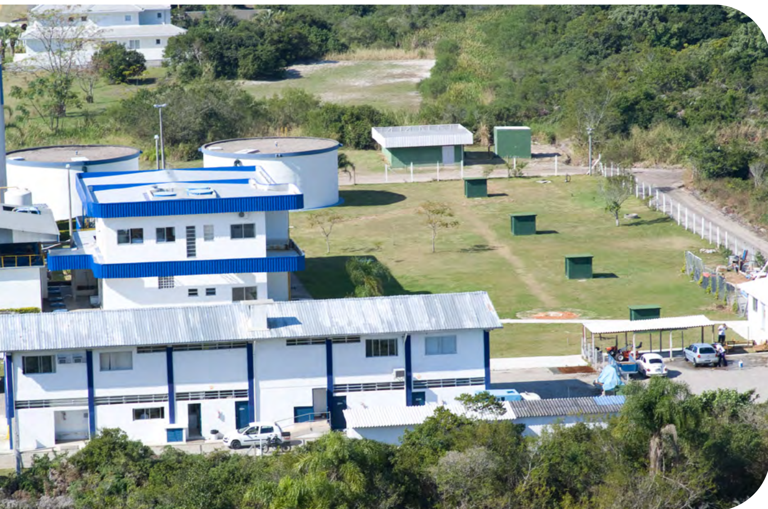
Estação de Tratamento de Água - SAE
