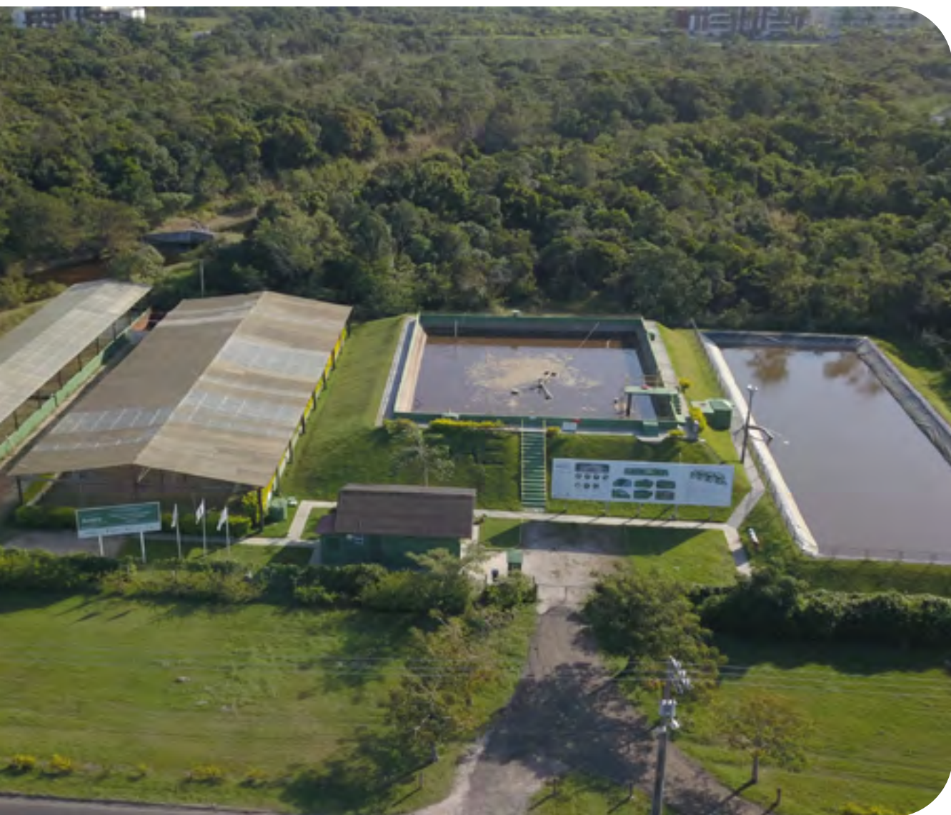
Estação de Tratamento de Esgoto (ETE) - SAE
