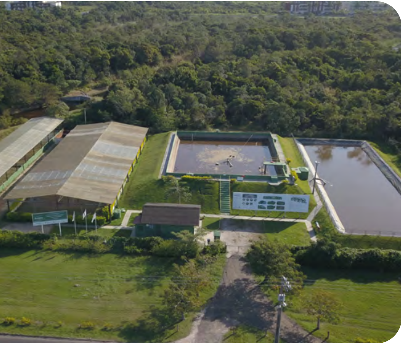
Estação de Tratamento de Esgoto (ETE) - SAE
