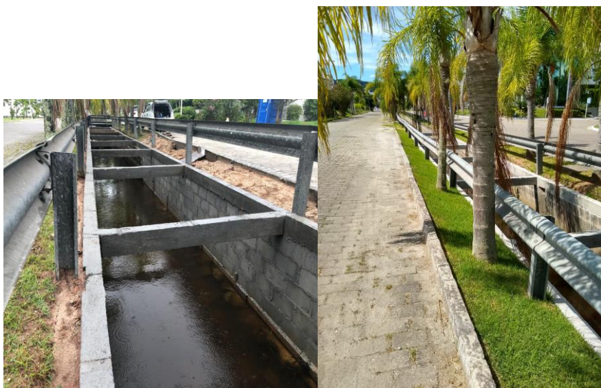
Foto 4 ( crédito foto: Ricardo Padilha): Antes e depois – Canal Avenida dos Dourados
